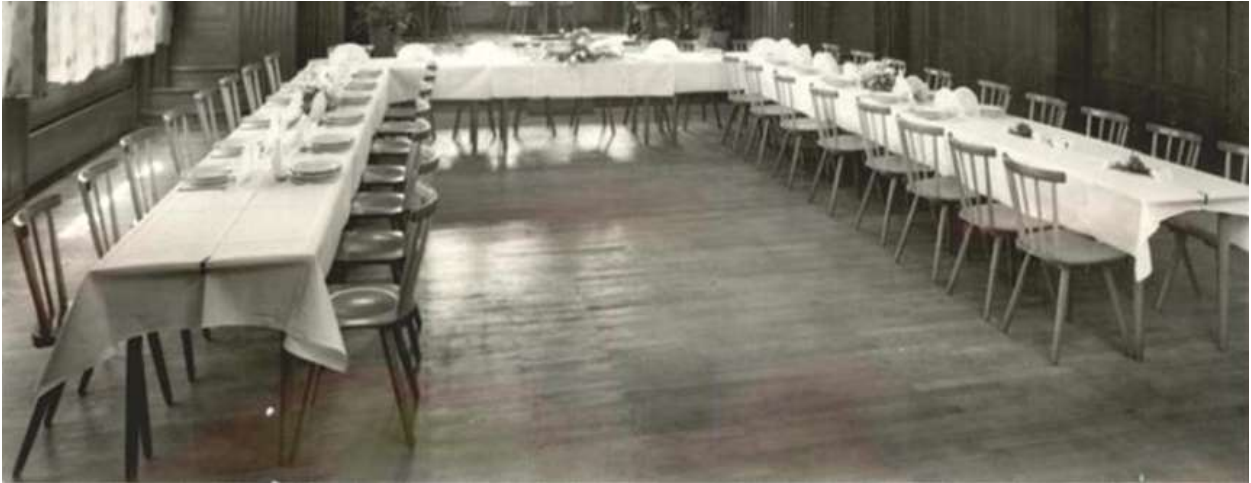
Ehem. Rest. Kanonenbäck, Stuttgart
