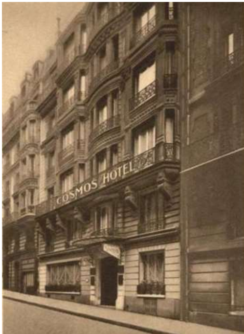
Ehem. Hôtel Cosmos, 14, rue Lentonnet, 75009 Paris (1934)
